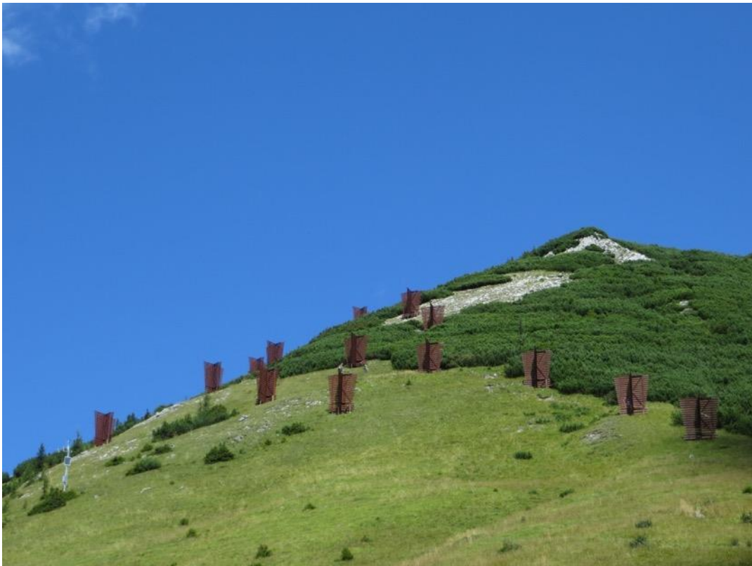
Abbildung 13: Lawinenverbauungen am Lahnerkogel (Foto: Verfasserin)
