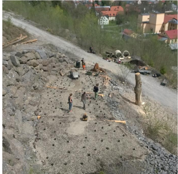
Vorbereitung der untersten Berme für den Lehrpfad. (Foto: Naturpark Nagelfluhkette)
